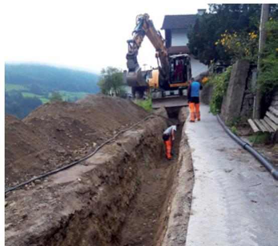
Grabungsarbeiten bei der Hauptwasserleitungserweiterung in Eggles mit Stromversorgung und LWL. Es wurden ca. 50 lfm Kabel LWL verlegt.
